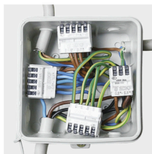
Kontrollfenster für korrekt abisolierte und eingesteckte Leiter
