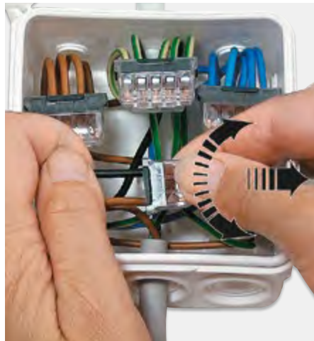
Lösen des Leiters durch Drehen und Ziehen Release the wire by twisting and pulling
